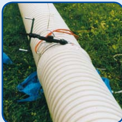
Angeformte Elektroschweißmuffe
